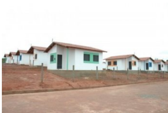
500 casas do Loteamento Vale do Gavião entregue em 2008.
