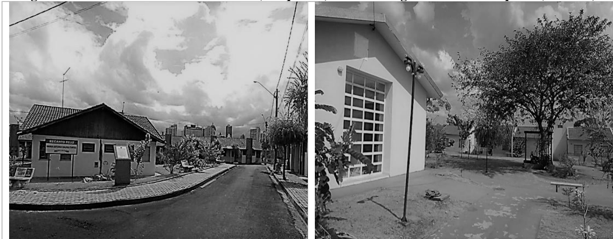
Figuras 3 e 4: o interior do Recanto Feliz (à esquerda) e do Vila Dignidade de Araraquara (à direita)
